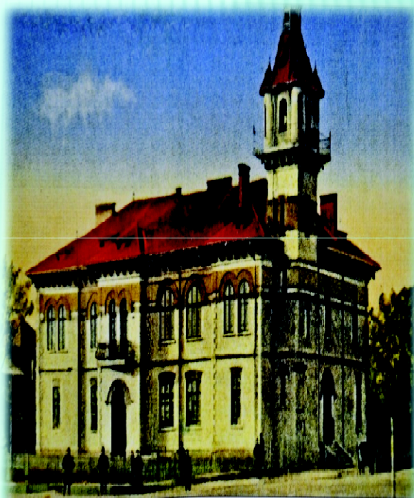
Vedere generală cu Palatul Administrativ, după reparațiile din anul 1937.
